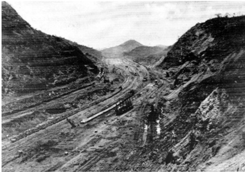
Trabajos en el Tajo de Culebra. (Archivo Espasa)
