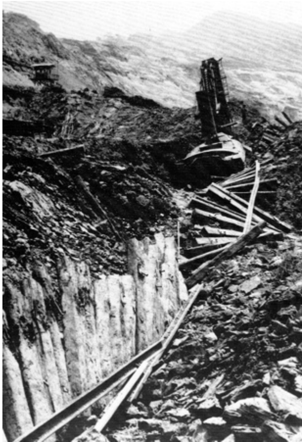
Secuela de un deslizamiento de tierra ocurrido en el Tajo de Culebra. (Compañía del canal de Panamá)
