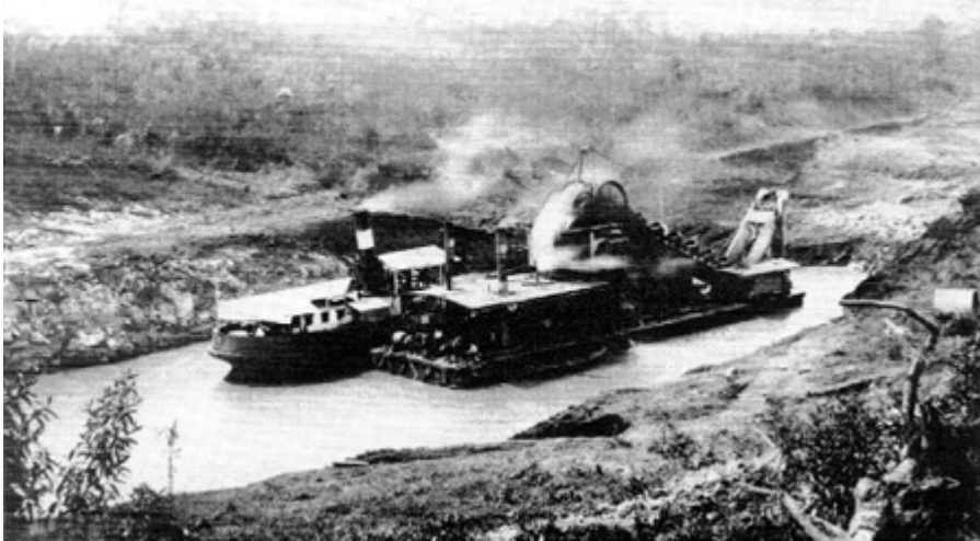
Draga de escalera francesa en funcionamiento. En máquinas como esta basó Bunau-Varilla su novedoso plan para salvar a la empresa francesa durante su desesperado final. (Compañía del Canal de Panamá)
